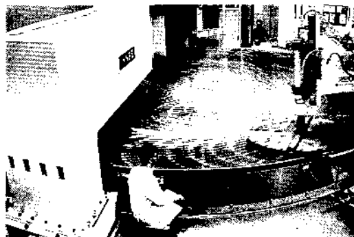
図24 ゼロデュア8mφ鏡の加工工程
